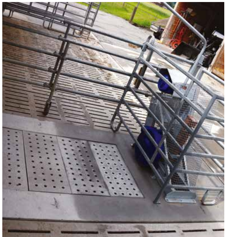
Schaufelrührwerk nachträglich in Laufhof eingebaut.
