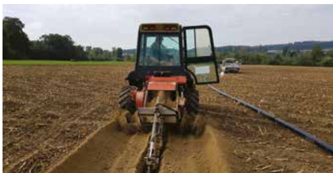
Bodenleitungsbau, PE geschweisst oder PVC gemufft. Inklusiv Druckprüfung!
