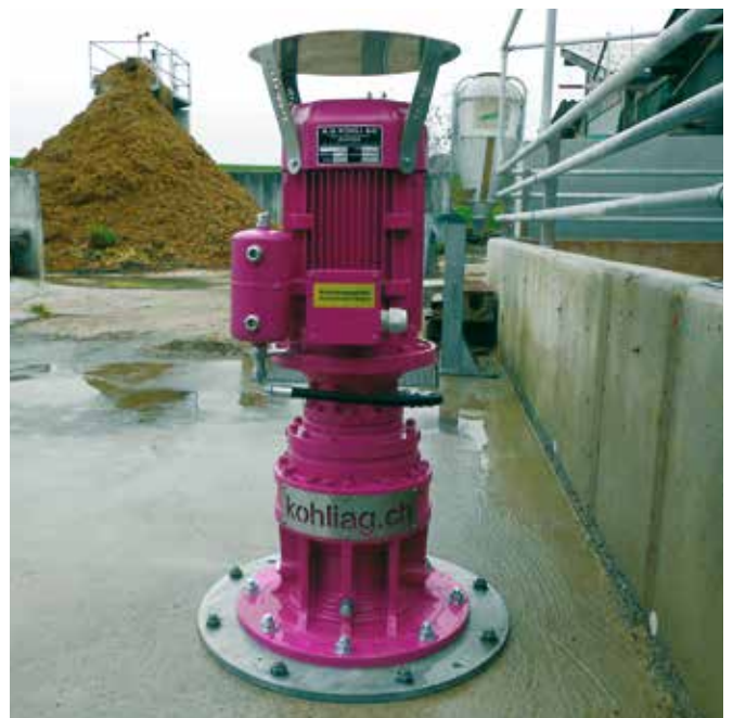
Fest auf Grubendeckel oder Betonsockel montiert
