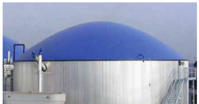
Doppelmembran-Dach für Bio-Gas Anlagen
